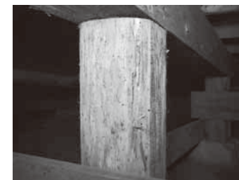
②特定現況検査（木食い虫による束の被害）
