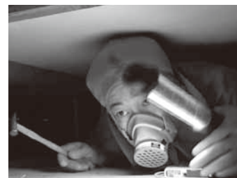
①特定現況検査（床下）
