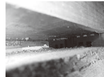
④特定現況検査（床下、基礎パッキンに蟻土付着）
