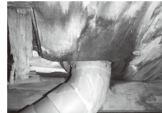
⑥特定現況検査（水漏れによる腐れ）
