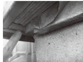
③特定現況検査（水切りの木部に蟻土）
