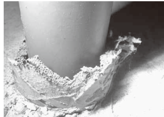
⑤特定現況検査（配管に付着した蟻土）
