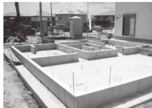
① 一体打ちべた基礎の防蟻効果は高い
