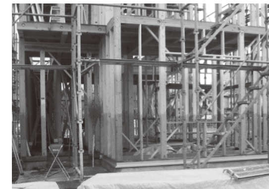
③ 下端1mに合成殺虫剤(防蟻剤)を木部処理した柱
