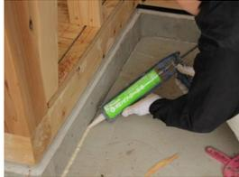
シロアリが侵入可能な隙間は、ヤマトシロアリが0.6~1.0mm程度、イエシロアリが1.1~1.3mm程度であり、玄関土間の基礎コンクリート打継ぎ目地部分は侵入経路の1つになる。写真は「ポレイトシール」を用いてシーリング処理を行っている様子
