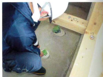
スリーブ管の隙間に「ボレイトシール」「ボレイトフイラー」を施工
