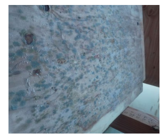
建築中の剛床にカビが生えている。原因は床下に貯まった雨水である
