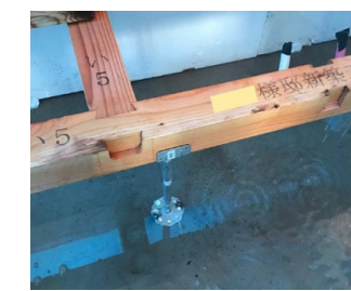
左写真の床下。雨水が貯まっている
