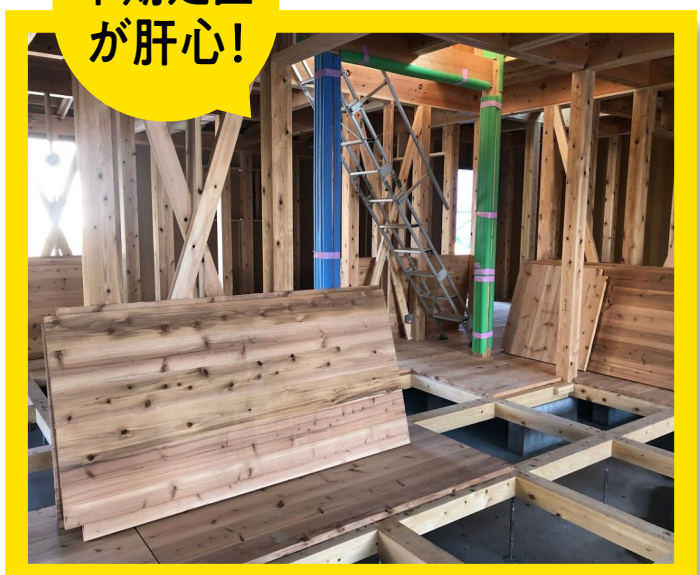
基礎断熱で先行床の場合は、床が閉じられたままなので、床下に貯まった雨水に気づかない、くみ出せない、乾燥しにくい。気づいたときには床板がカビだらけなんてことになりかねない。床板は仮留めにし、上棟後に床板を開けて床下の乾燥を促したい
