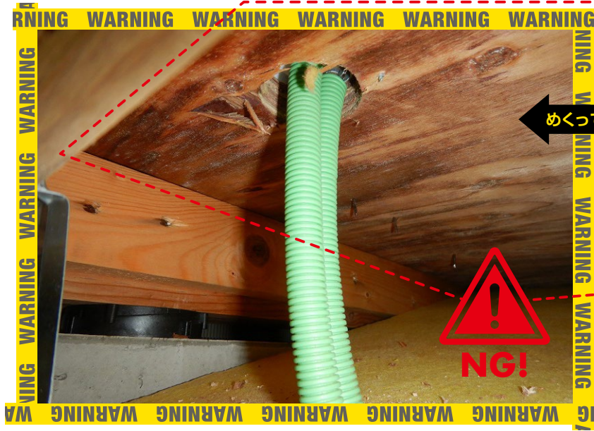
床下にグラスウール断熱材が納まっている。一見すると、不具合は見当たらない
