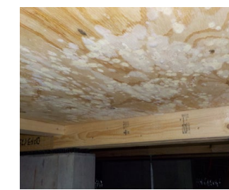
引渡し前に発見した基礎断熱の床板のカビ。建築中、床下に貯まった雨水を放置したことが原因と考えられる
