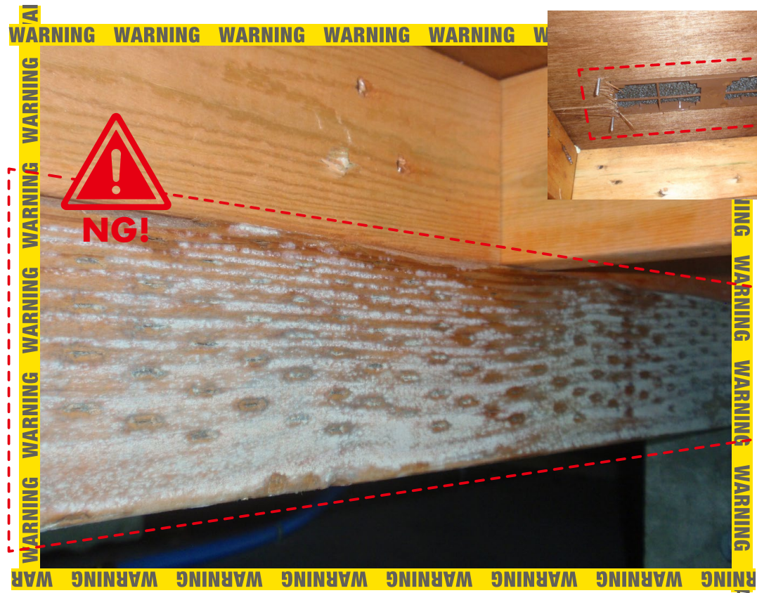
築5年で大引などにびっしりカビが生えた。1階床面積20坪弱で、はがき2枚分の換気口が1つあるだけ。明らかな換気量不足が一因と考えられる
