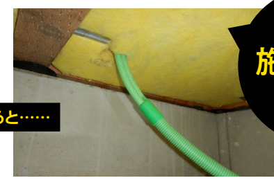
床下にグラスウール断熱材が納まっている。一見すると、不具合は見当たらない
