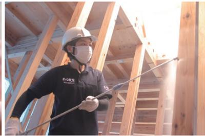
ポロンdeガードは、責任施工によるホウ酸防腐防蟻処理。安全性と効果の持続性に優れ、高性能住宅の劣化対策に適している。長期優良住宅対応
