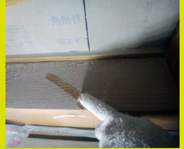
施工後の状態
